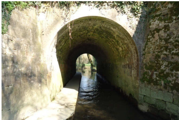
Figure 8 : pont voûté (photo : Etienne Ouvrard)
