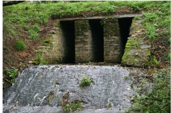
Figure 6 : pont dalot (photo : Julien Sudraud)
