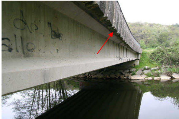
Figure 9 : pont en béton. Les Chiroptères se tiennent dans les encorbellements (photo : Julien Sudraud)
