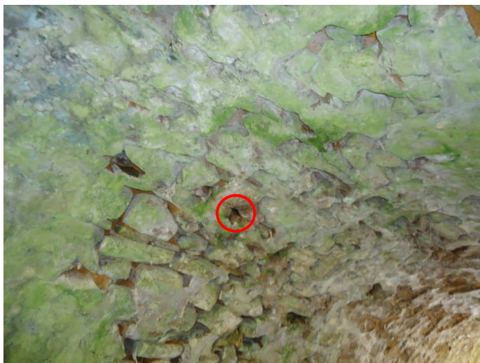
Figure 31 : disjointements sous un pont voûté départemental (photo : Etienne Ouvrard) avec indication de l'unique cavité utilisée par les chauves-souris.
